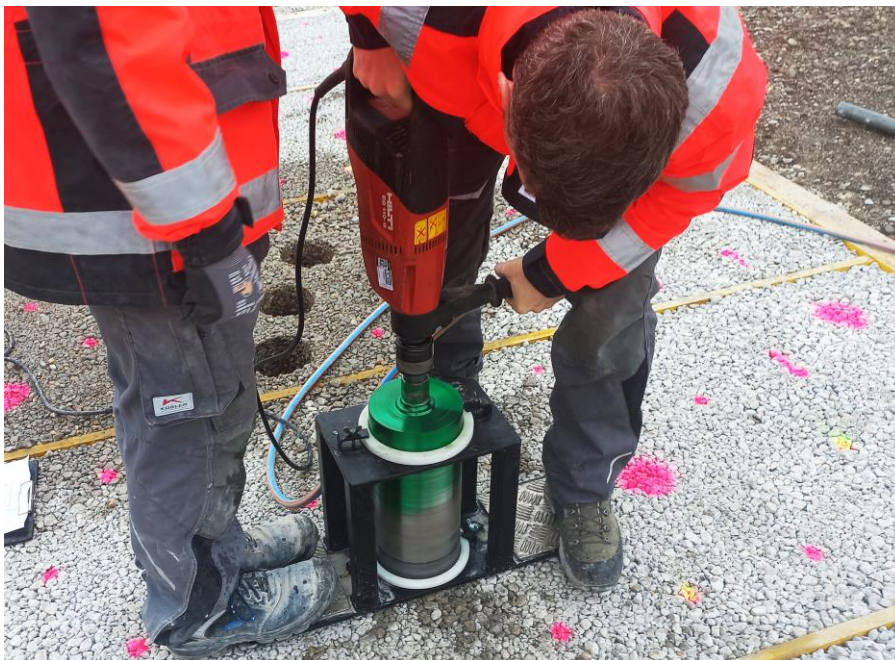
Abb. 3: Manuelles Bohren mit der eigens konstruierten Bohrhilfe.
