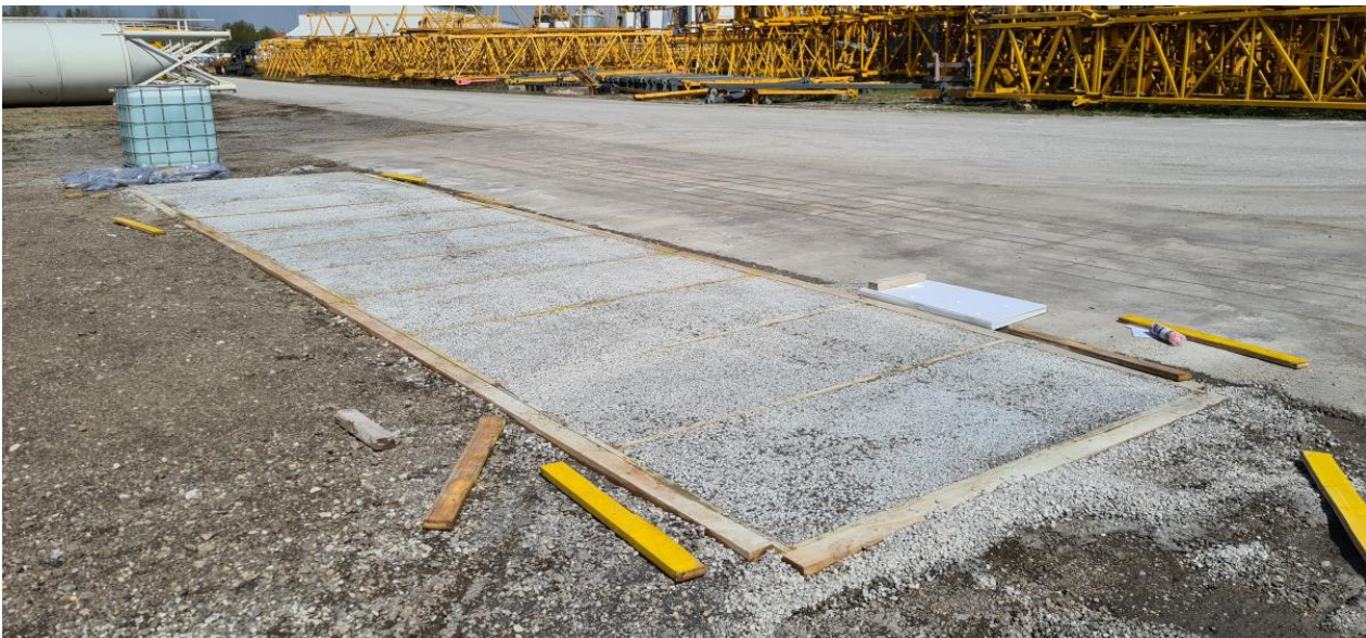
Abb. 2: Zustand der Versuchsfläche vor Beginn der Bohrungen.
