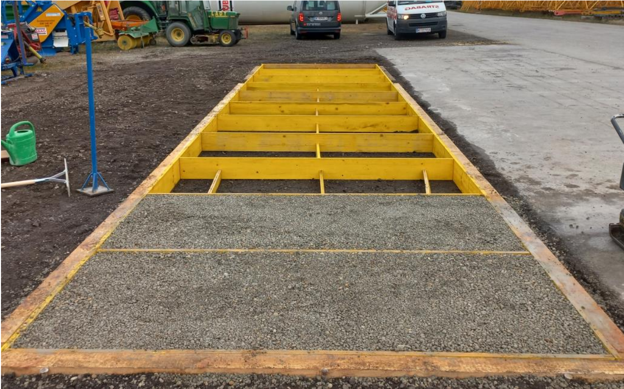
Abb. 1: Schalungen der 11 nebeneinander liegenden Versuchsfelder nach (erstmaligem) Einbau der Felder 1 und 2.
