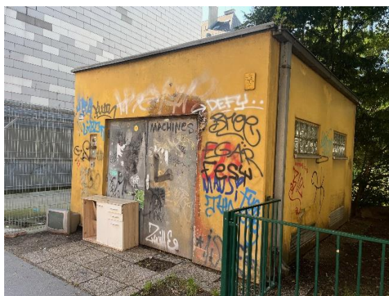
Anlage 6: Beschmierungen im Außenbereich
