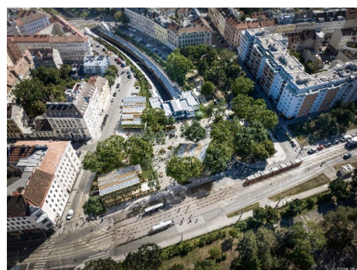
Abbildung 3: Klimafitter Hauptplatz Penzing
